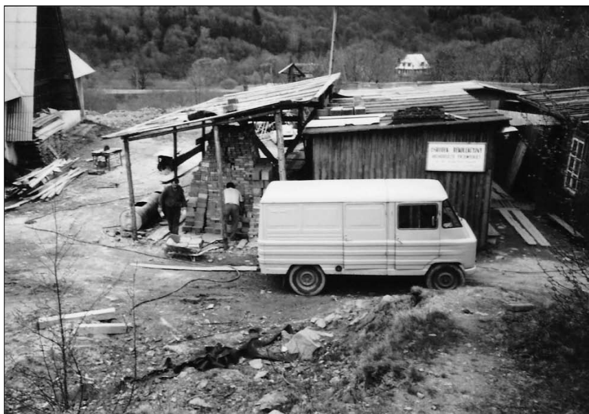
Drewniane baraki, które służyły grupom rekolekcyjnym do czasu wybudowania domu rekolekcyjnego.
