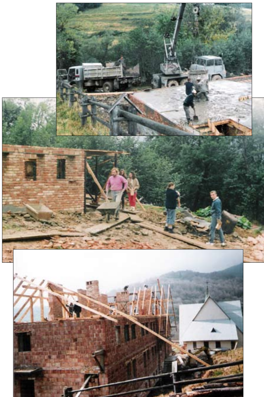
Budowa Domu Rekolekcyjnego im. Jana Pawła II w Ustrzykach Górnych.
