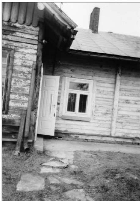
Wygląd Ośrodka przed zakończeniem remontu.
